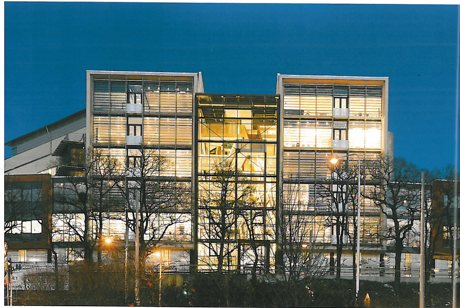
1. Fasaden mot öster med det helt glasade mitskeppet.
